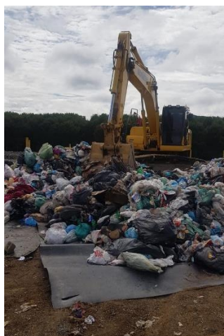
Figura 8 - Quarteamento dos materiais
