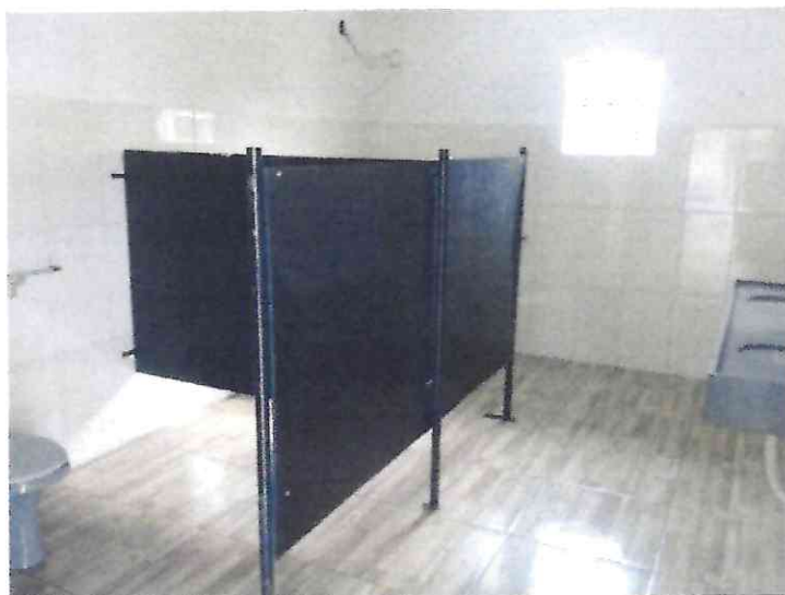
Foto 12: Banheiro feminino adaptado
